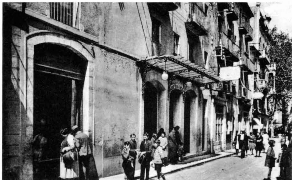
Entrada de la nova Sala Edison inaugurada el 1914 que encara es conserva.
